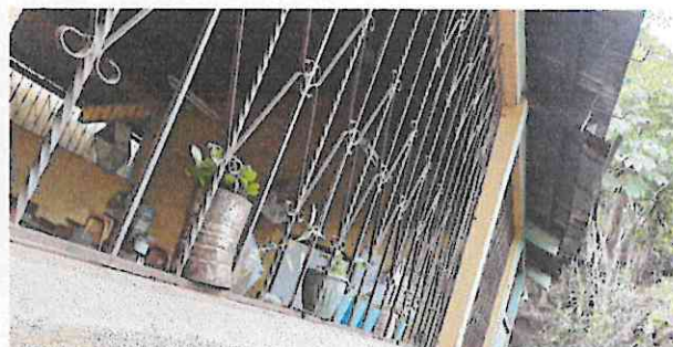
Foto 6: Mantenimiento de ventanas.
